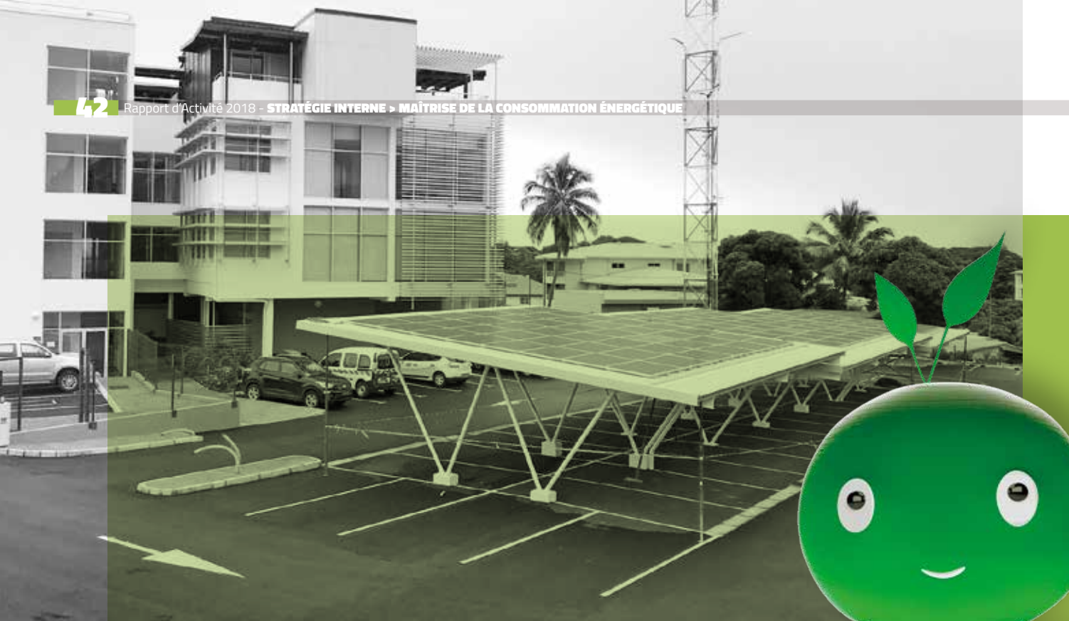
Panneaux photovoltaïques posés à l'agence de Koné.
