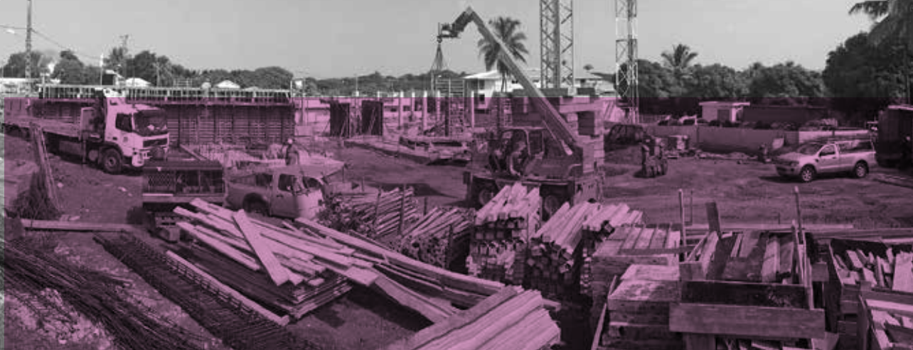
Les travaux de l'immeuble de Koné - Avril 2016
