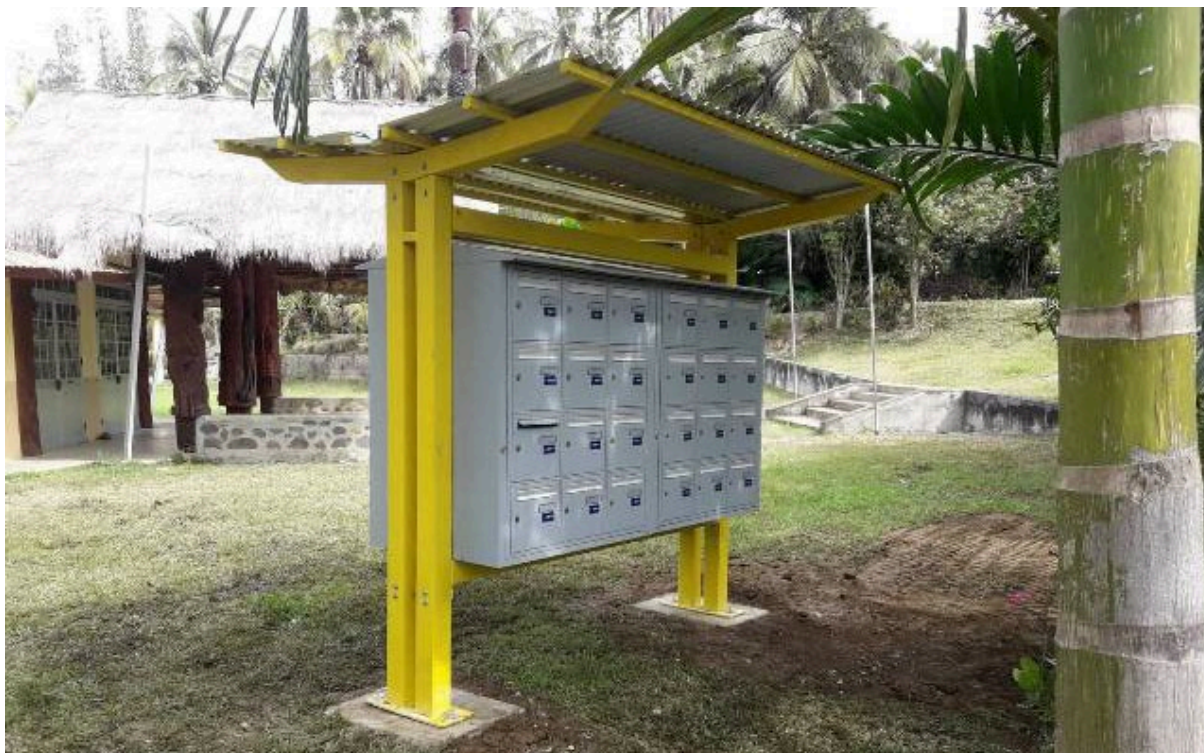
GOHAPIN -3 – Maison commune - Installation de 48 nouvelles boîtes postales, correspondant à 4 panneaux de 12 boîtes. Structure sur poteaux.
