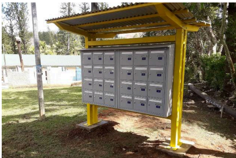
Installation de 48 nouvelles boîtes postales, correspondant à 2 panneaux de 24 boîtes. Structure sur poteaux.
