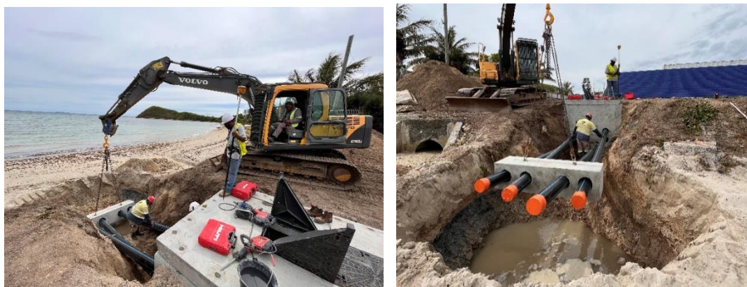
Construction de la chambre de plage de Nouville le 23 novembre 2021
