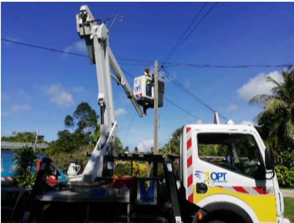
Travaux de raccordement à la fibre optique sur Lifou
